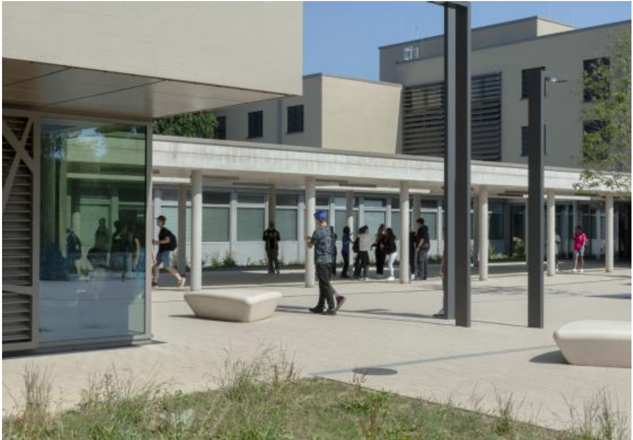
Liaison entre la nouvelle extension et le bâtiment existant après rénovation
