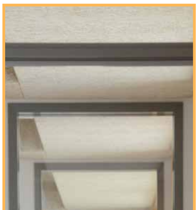
← Foto 10: Akustische Deckenisolierung, Grundschule Lorentzweiler, Luxemburg
